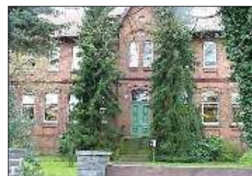
Außenstelle Alte Schule
