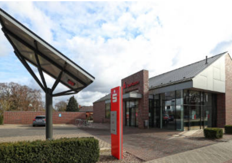
Die Filiale im Gifhorer Ortsteil Gamsen mit ihren freistehend installierten Photovoltaik-Elementen
